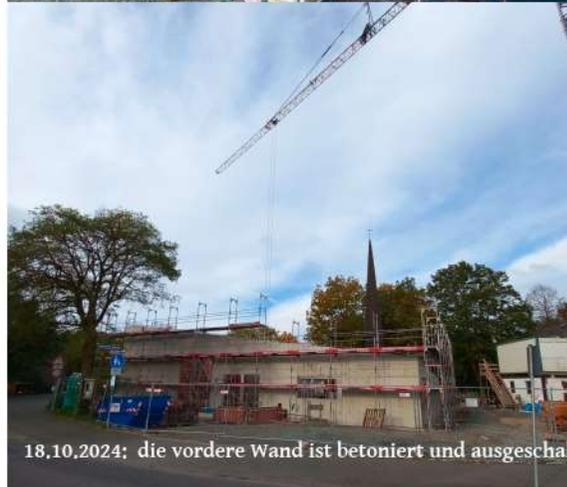
18.10.2024: die vordere Wand ist betoniert und ausgeschalt
